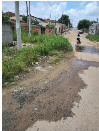
Saliento ainda, que a retirada do acúmulo de terra e consequente limpeza, além de propiciar melhor escoamento das águas, dificultará que nova vegetação se forme sobre a sarjeta e o asfalto.
