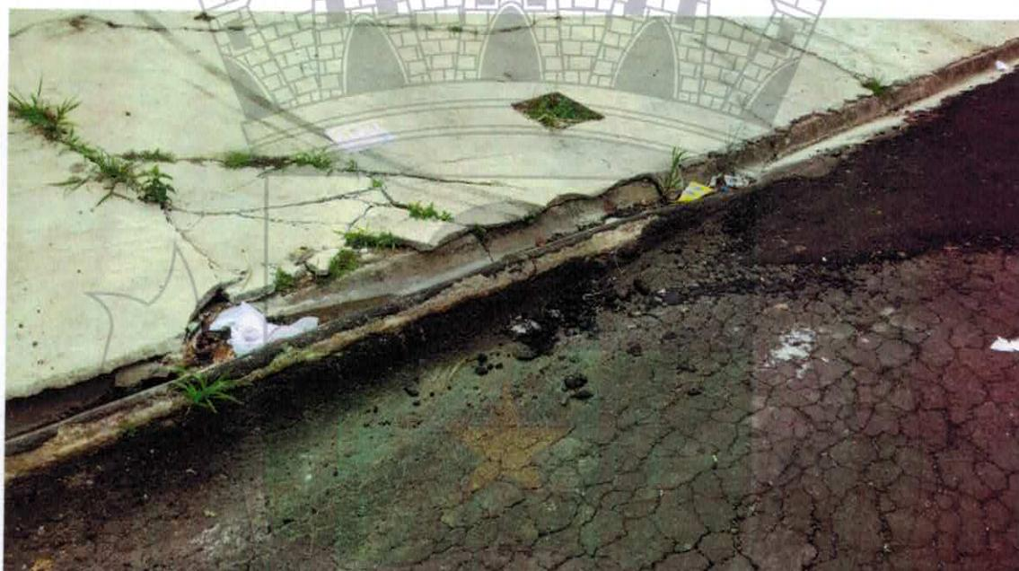
Com isso, a calçada do imóvel também começou a deformar devido à pressão que a guia exerce nela e também com a infiltração de água que desce pela via.
