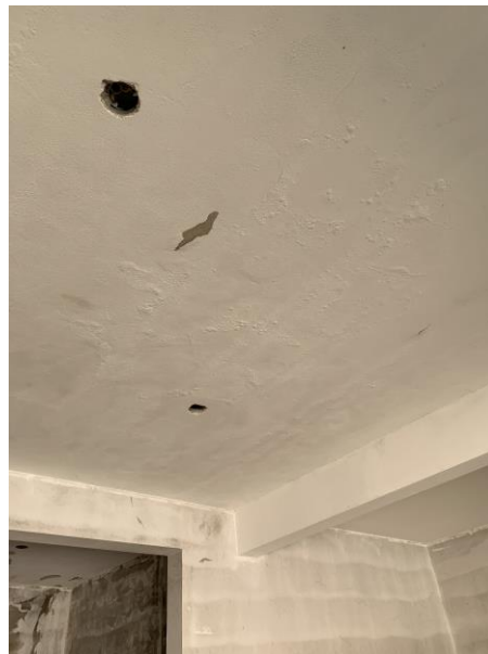
Problemas nas futuras salas de aula, devido a infiltrações causadas pelas chuvas.
