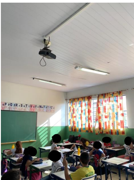
Forro abaulado pela infiltração no teto da escola.
