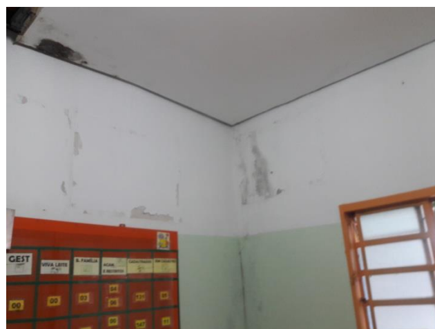
Parede com infiltração - sala de reunião dos Agentes da Saúde
