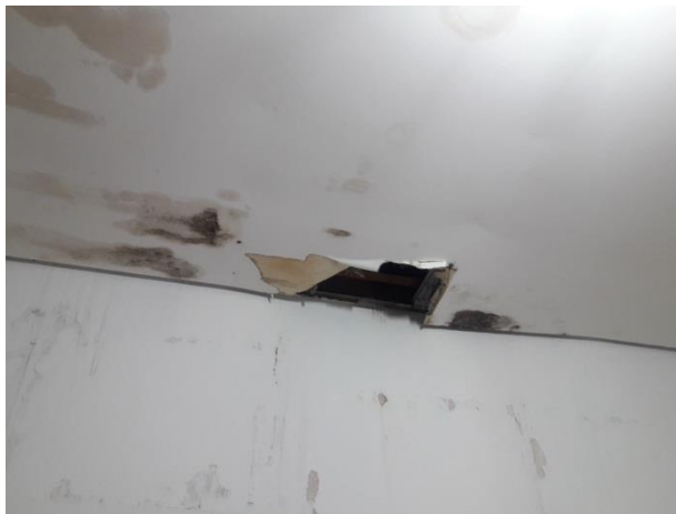
Parede com infiltração - foto de outro ângulo - sala de reunião dos Agentes da Saúde
