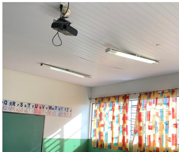
Luminária da sala que balança quando chove, causando pânico nos alunos.
