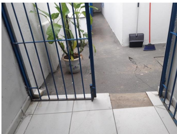
Piso com rachadura e faltando piso
