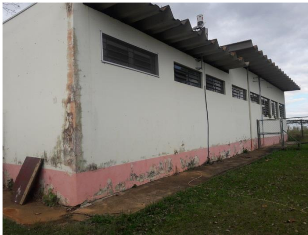
Infiltração e pintura descascando
