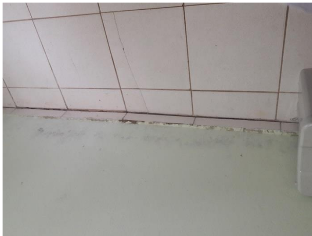
Ocorrência de recalque no piso da sala de reunião dos Agentes da Saúde
