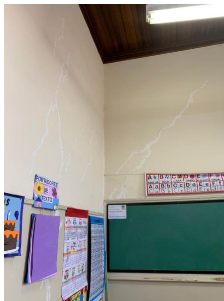
Rachadura vista de dentro da sala de aula.
