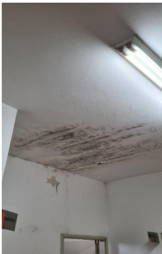
Umidade e mofo no teto
