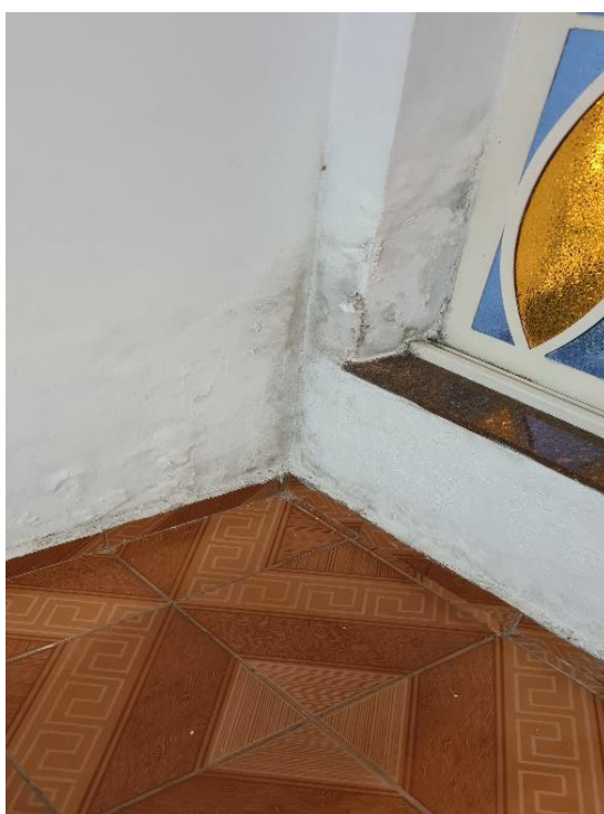
Paredes com infiltração
