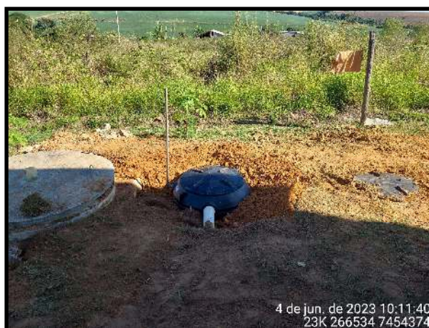
Figura 09. Sistema Individual de Tratamento de Esgotos: fossa séptica, filtro anaeróbico e sumidouro.
