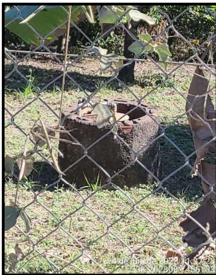
Figura 05. Poço tubular profundo de sistema individual de abastecimento de água.
