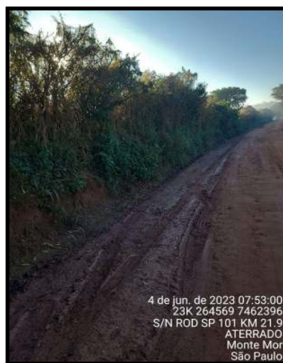
Figura 12. Inexistência de sarjeta de drenagem no viário.
