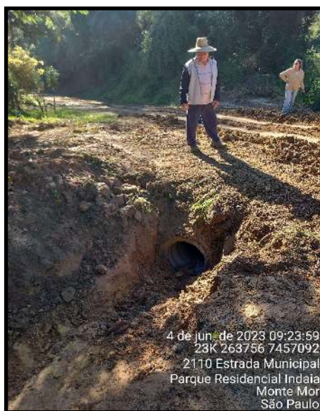
Figura 18. Travessia subterrânea de drenagem com inadequações.
