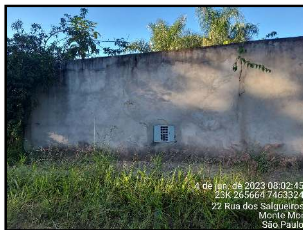
Figura 04. Unidade de Medição de Água (UMA) da Sabesp, instalada numa residência na área rural.
