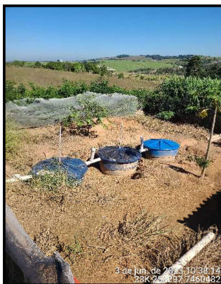
Figura 08. Sistema Individual de Tratamento de Esgotos: fossa séptica, filtro anaeróbico e sumidouro.
