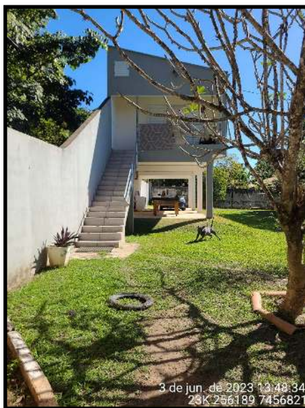
Figura 27. Edificação construída acima do nível da rua para evitar as enchentes do rio Capivari no Chácaras Planalto, Monte Mor.
