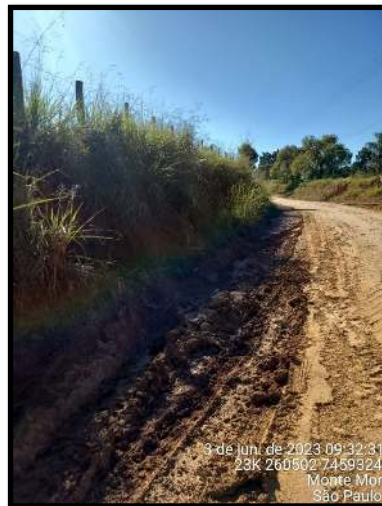
Figura 13. Falhas na drenagem devido à falta de drenagem.
