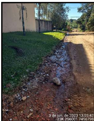
Figura 11. Inexistência de sarjeta de drenagem no viário.
