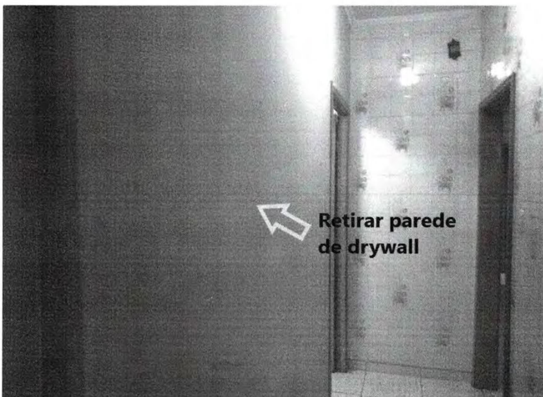
Foto 14: Retirar o fechamento de drywall.
