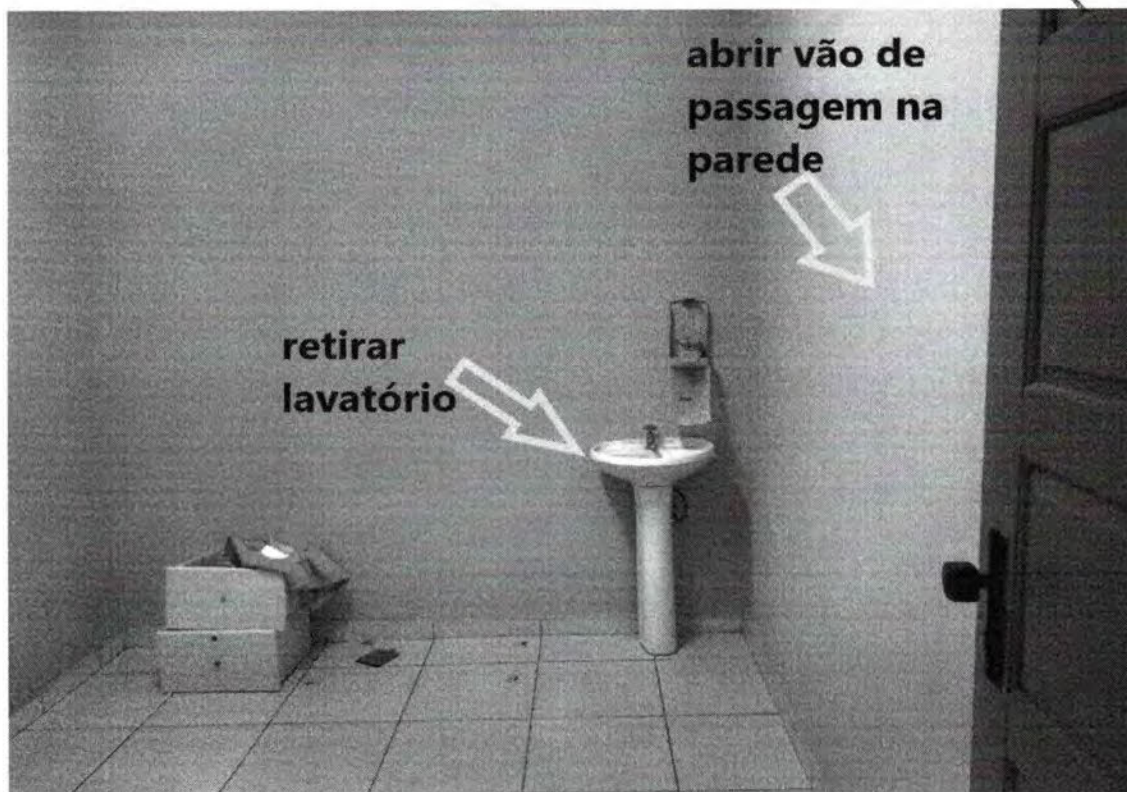
Foto 5: Retirar o lavatório sala anexa e abrir vão de passagem na parede.
