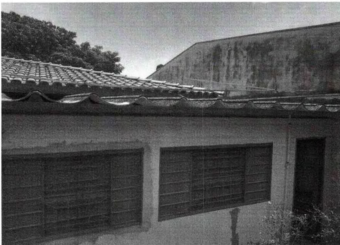
Foto 17: Retirar tinta do vidro e pintar na cor branca e reparar reboco.
