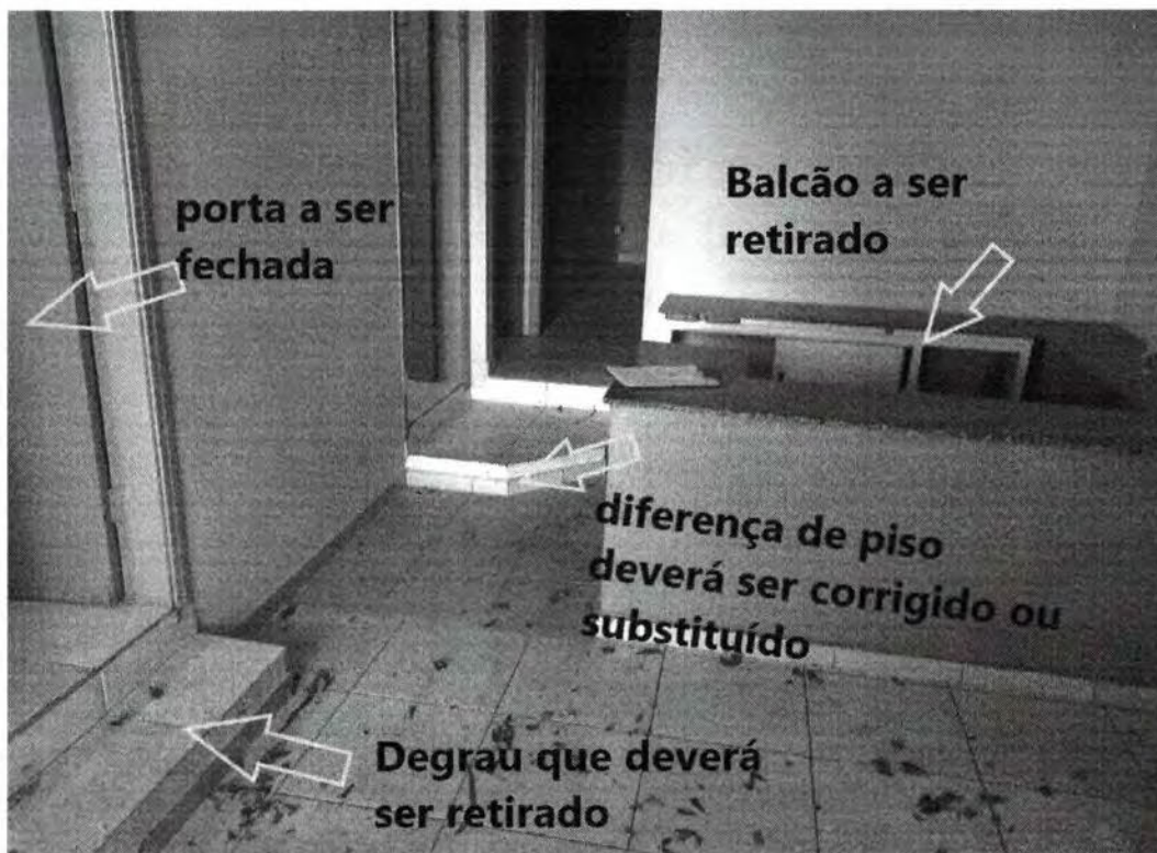
Foto 1: balcão e degrau a ser retirado, porta ser fechada e a questão do piso.
