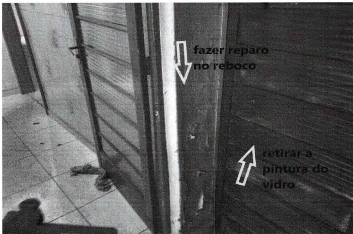
Foto 15: Retirar tinta do vidro e pintar na cor branca e reparar reboco.
