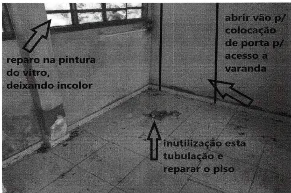
Foto 16: Retirar tinta do vidro e pintar na cor branca e reparar reboco.
