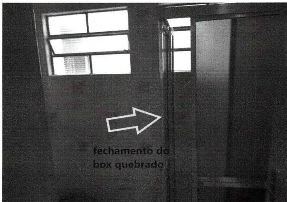
Foto 12: Reformar ou substituir o fechamento do Box.
