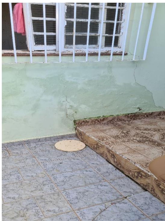
Paredes com infiltração
